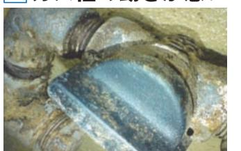
ガス栓や器具栓が劣化すると、すき間からガスが漏えいします。
